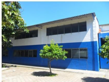
Fachada posterior. Edificio 1.
