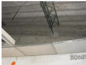
Parte interior del techo.
