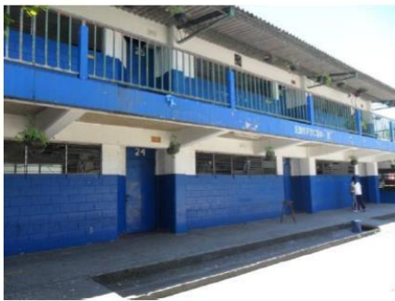
Fachada principal. Edificio 1.
