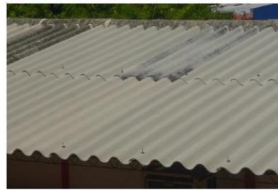
Parte exterior del techo.
